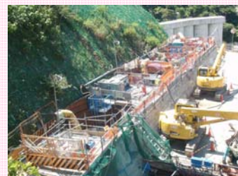
よう壁(工事中)
