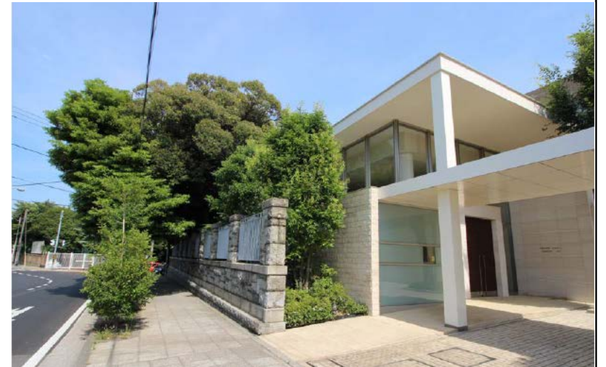
既存樹木を生かした建替例
