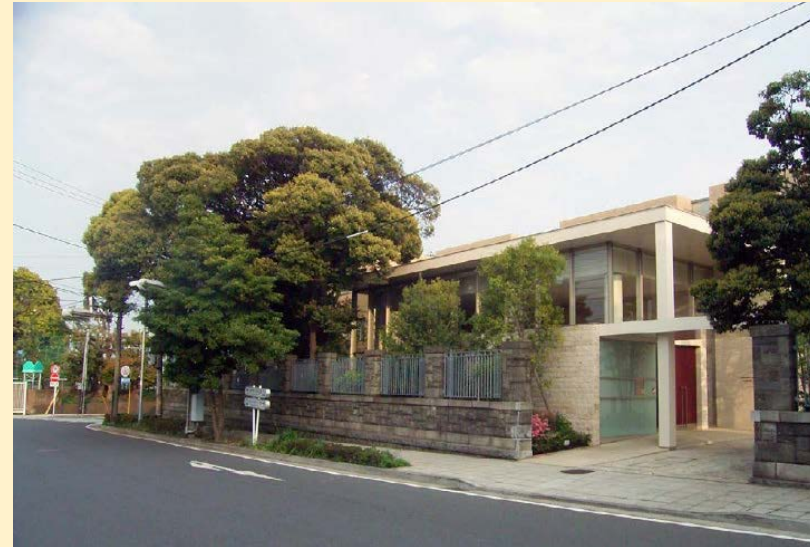
既存樹木を生かした建替例
