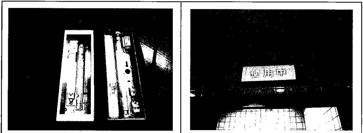
経年劣化にともなう、表示板のLED化および人感センサー、天井照明の交換
