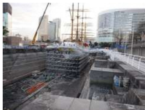
外板補修及びリベット摩耗箇所補修
