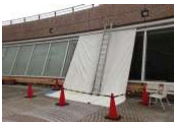
壁面タイル修繕工事
