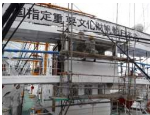
船橋全面窓枠周り鋼壁補修
