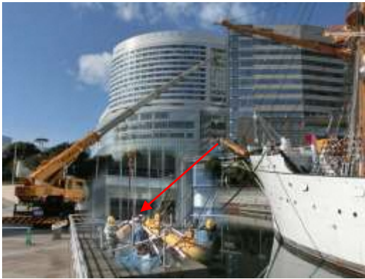
バウスプリット工事
