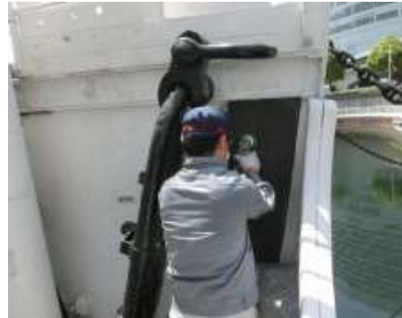
船体鋼材整備作業 発錆部手入れ
