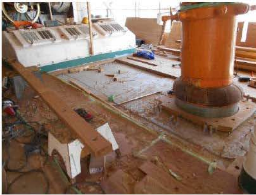
各部木甲板交換・漏水部補修
