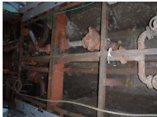
機関室内タンクトップ塗装
