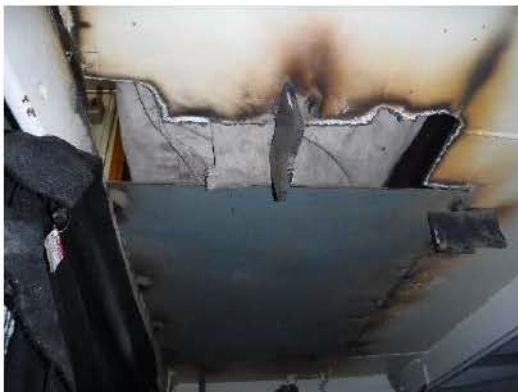
凹甲板防災センター床下補修
