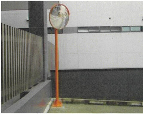
(施工後 カーブミラーにより死角の解消)
