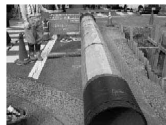
管が直接、土に触れないようにポリエチレンスリーブを施した配水管
