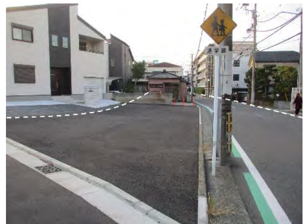
歩道整備 市道上大岡第149号線・第168号線(南区大岡五丁目)
