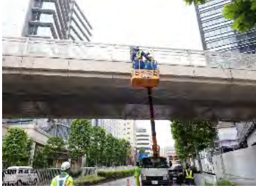
劣化状況の近接目視 すずかけ通り歩道橋(西区)
