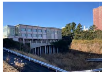
【雨水調整池上部の利活用】野庭団地第一雨水調整池
