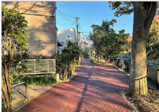
舗装の改修 (栄区:花や鳥、豊かな自然に出会ういち川ルート)
