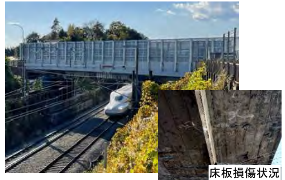
計画的な補修: 第1柳明橋(泉区)
