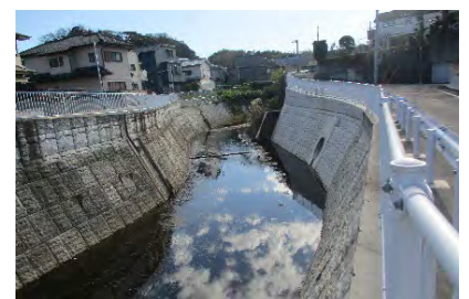
河川改修 (護岸整備: 日野川)
