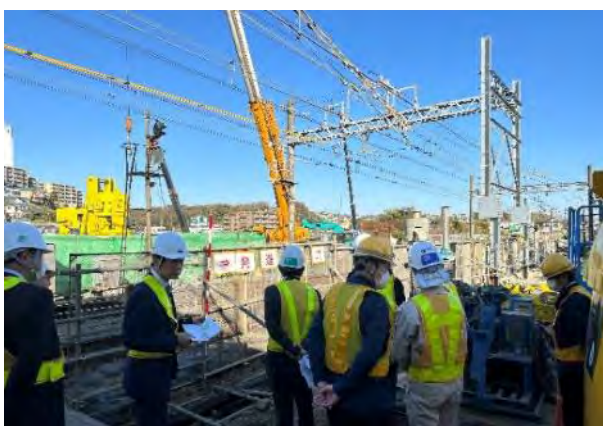
有識者による現場視察(発進立坑部)
