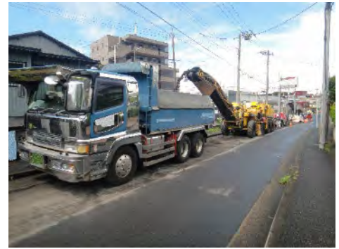
舗装修繕工事の状況(旭区)
