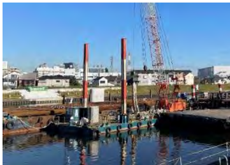
河川工事状況(橋脚を施工中)
