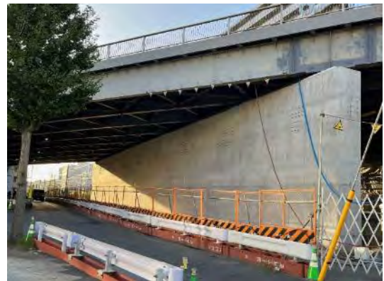
耐震補強工事：新横浜陸橋（港北区）
