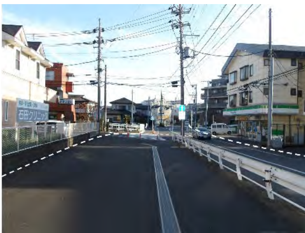
歩道整備 市道上白根第99号線(旭区白根六丁目)
