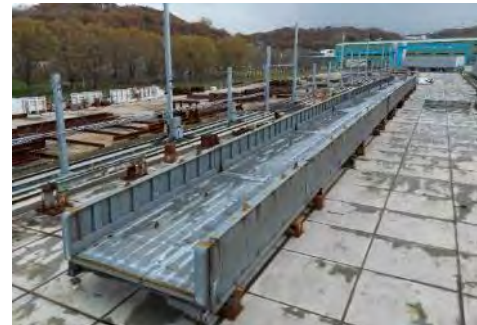
桁部製作状況
