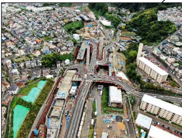
(仮称)公田IC築造工事(栄区公田町)公田小学校下交差点付近
