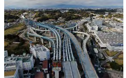
横浜環状南線・横浜湘南道路 (高架橋整備: 栄IC・JCT)
