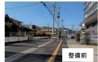
無電柱化の状況 (港南区役所)
