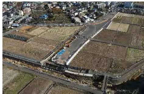
奈良川を横断する橋梁工事
