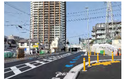
都市計画道路整備事業 (令和4年度開通: 鴨居上飯田線)
