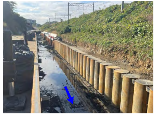
護岸改修、橋梁架替え、用地補償 (今井川：保土ヶ谷区権太坂一丁目)
