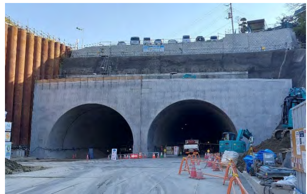
桂町トンネル工事
