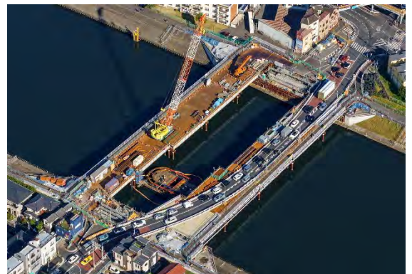
老朽橋架け替え: 末吉橋(鶴見区)
