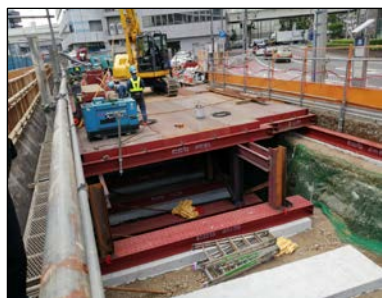
【護岸復旧工事】
