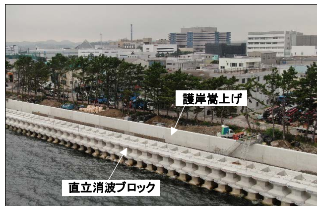
【福浦地区の復旧状況】
