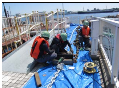
【ボツーン係留チェーン交換】
