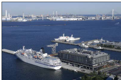
【新港ふ頭客船ターミナル】
