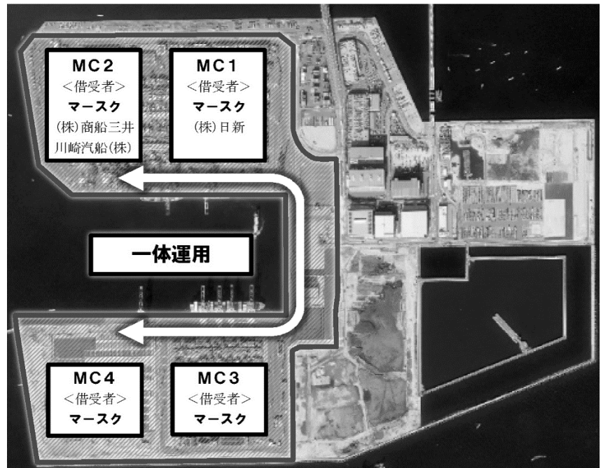
【南本牧ふ頭MC 1～4コンテナターミナル】
