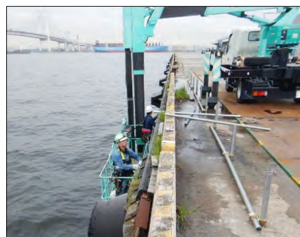
【岸壁補修工事】
