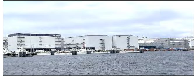
【本牧ふ頭A突堤のロジスティクス拠点】
