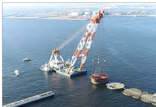
【鋼板セルの設置状況】
