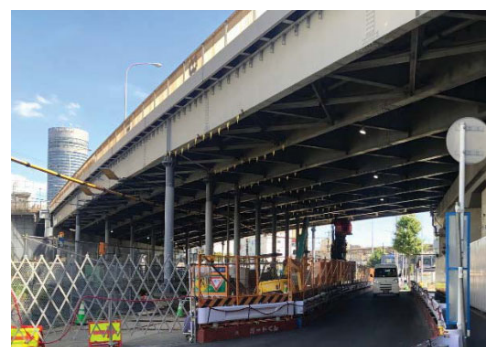
新横浜陸橋（港北区）
