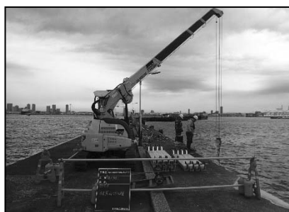
大黒ふ頭電気防食工事
