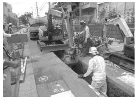
水道管更新工事の様子
