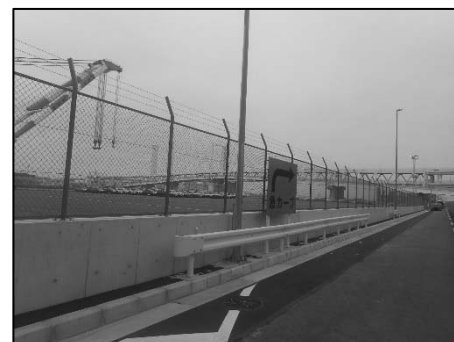
完了 (大黒ふ頭地区 胸壁整備)
