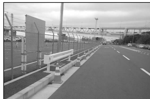
施工前 (大黒ふ頭地区 胸壁整備)
