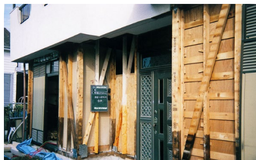
<木造家屋耐震補強工事の事例>
