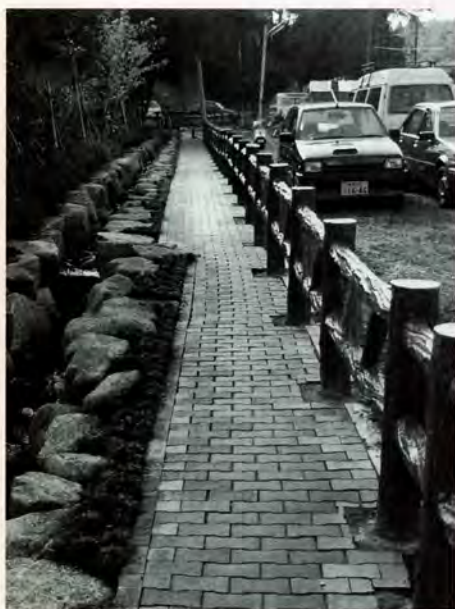
下水道汚泥で作ったレンガを活用した、上菅田町の小川アメニティ
