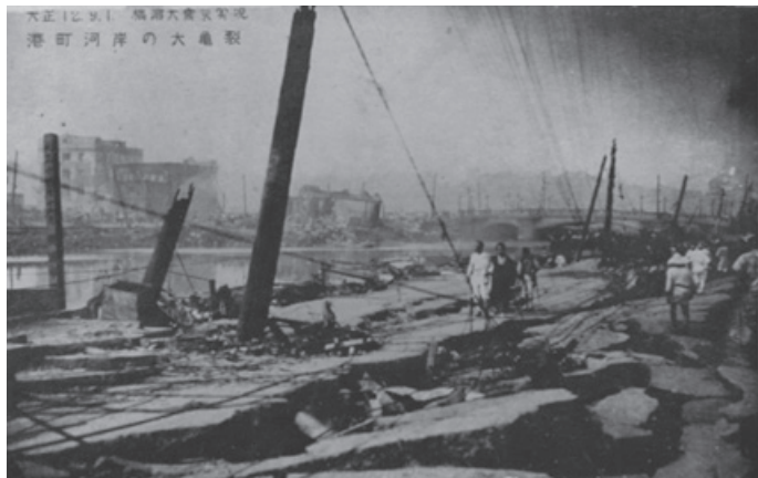
①港町河岸の大亀裂(資料群2、資料番号:38-3233) 豊国橋付近から伊勢佐木町・吉田橋方面を望む。
