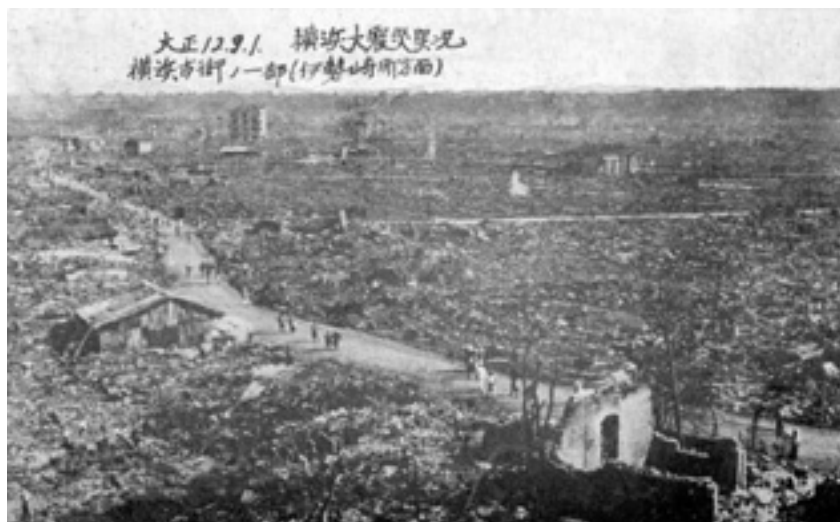
野毛坂の罹災状況 1923年9月頃
