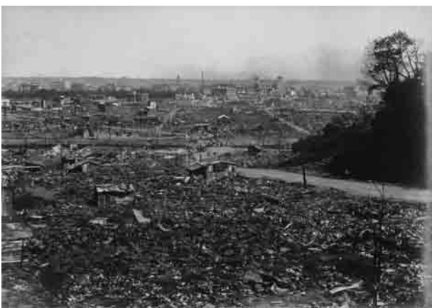
【図6】坂道の先、写真中央に作業中の工兵が確認できる。
