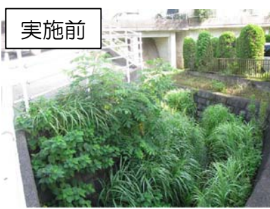
樹木伐採、除草 (侍従川支川)
