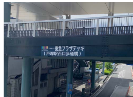
主桁への愛称標示 ※トツカーナ東急プラザデッキ(戸塚駅西口歩道橋)
