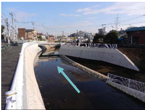
学校橋取付道路整備 (帷子川：旭区上川井町)
