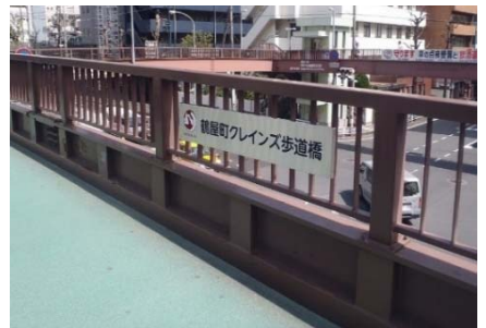
鶴屋町クレインズ歩道橋
