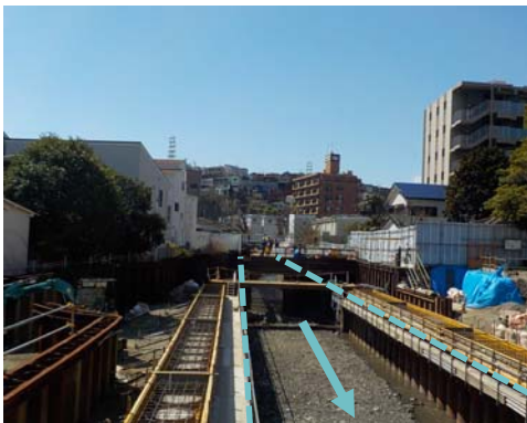
護岸改修 (今井川：保土ヶ谷区岩井町)
