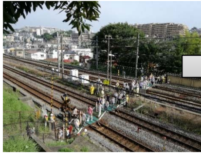
樹源寺踏切(保土ヶ谷区)現況
