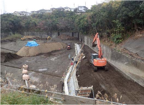
既設雨水調整池改良 (本郷台第一雨水調整池：栄区本郷台五丁目)
