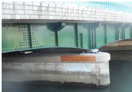
万里橋(西区):支承取り換え、落橋防止装置
