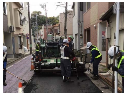
舗装修繕工事の状況(西区)
