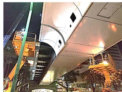
化粧パネルの撤去:みなと大通り1号歩道橋(西区) 令和2年7月完成
