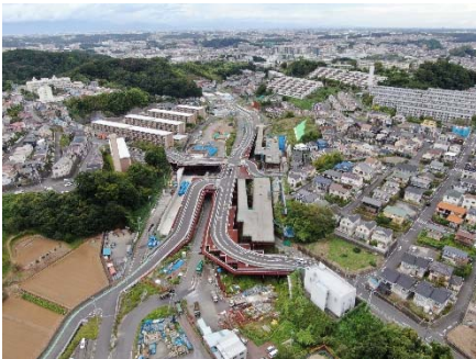
公田IC築造工事(栄区公田町)
