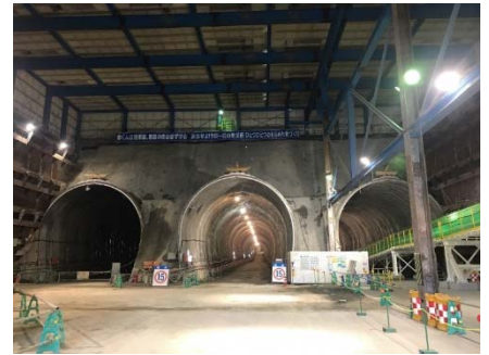
庄戸トンネル工事(栄区庄戸)
