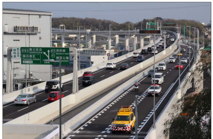
横浜北西線開通時の様子
