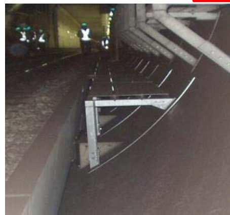
▲作業台設置状況【試験施工】
