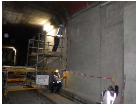
▲コンクリートの修復完了後
