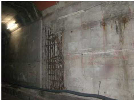
▲浮きがあるコンクリートを取り除いた状態
