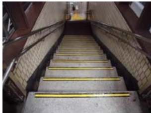
阪東橋駅改修例
