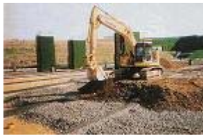
即日覆土の様子
