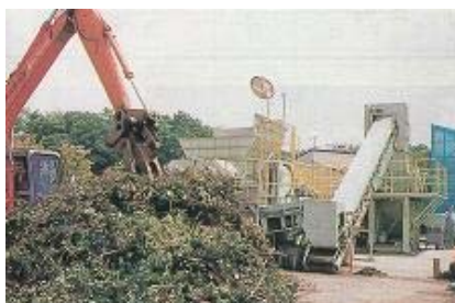
神明台処分地内グリーンコンポスト施設プラント
