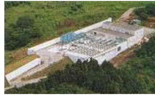
排水処理施設
