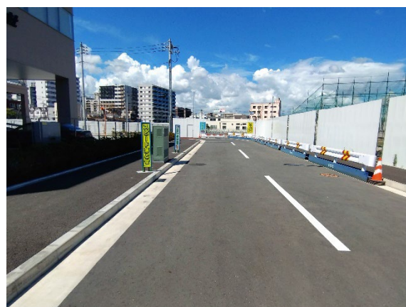
地区内道路の一部完成
