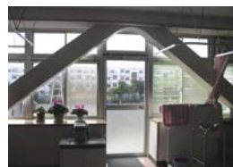
学校の耐震補強
