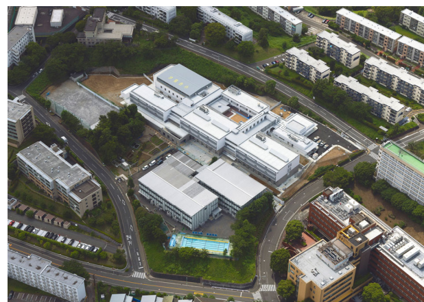
（仮設校舎と工事中の新校舎）
