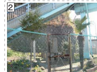
2 歩道橋の下の空間にある和田村道橋改修碑。金網に囲われている。
