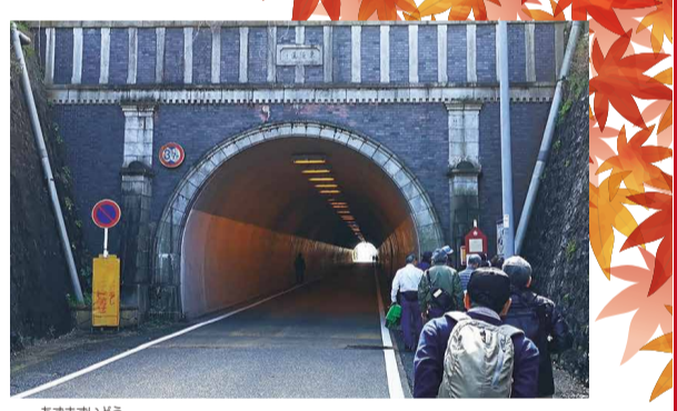
あすまいどう ▲東隧道(昭和5年築の市認定歴史的建造物/岩井町)
