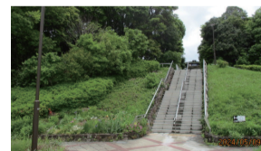
※並木北駅のエレベーター設置予定地
