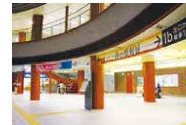
馬車道駅改札外 防災垂壁
