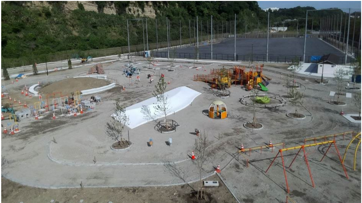
遊具広場・多目的広場全景
