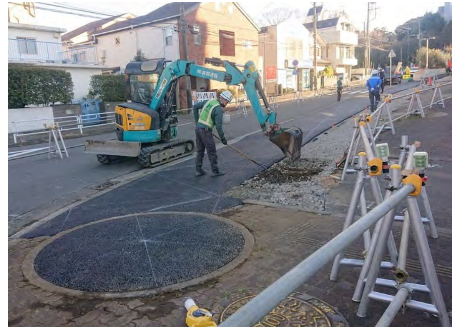
東側解体・仮歩道整備
