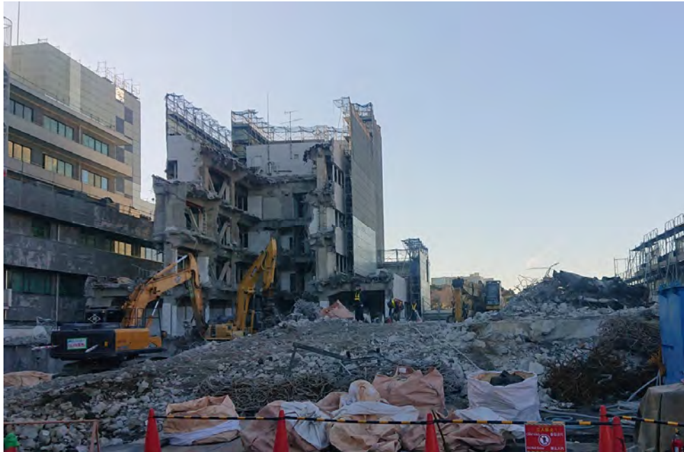
がん検診センター、緩和ケア病棟解体
