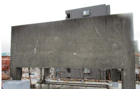
写真6 コンクリート高置水槽
