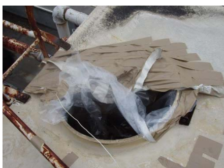
写真3 ビニールで蓋がされていた高置水槽
