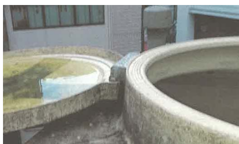
写真7 蓋の開いた高置水槽
