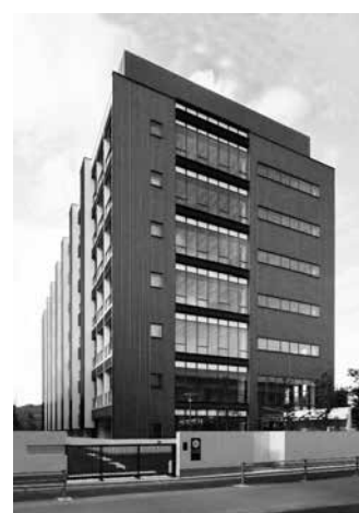
衛生研究所外観
