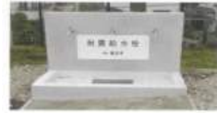
▲ 地域防災拠点に設置された耐震給水栓
