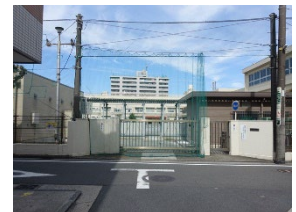
⑧グラウンド南側出入口を見る
