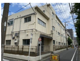
⑬東側道路より東校舎を見る
