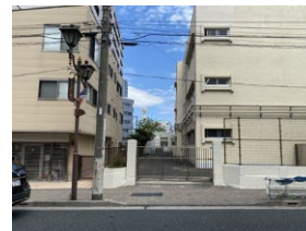
⑦北側出入口を見る
