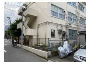
⑫南側道路より東校舎を見る
