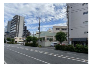
⑯県道14号線より給食棟と校舎を見る
