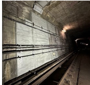
▲開削トンネル構築補修
