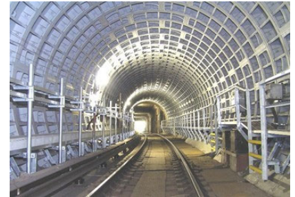
▲シールドトンネル構築補修
