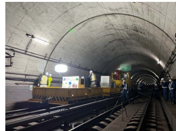
レーザーによる打音検査
