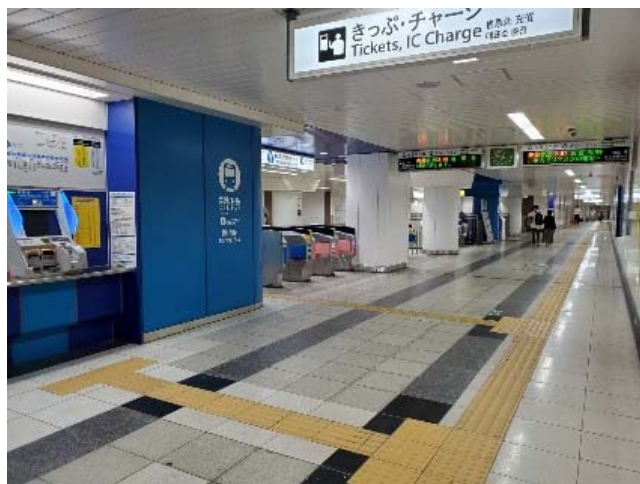
改良工事後関内駅
