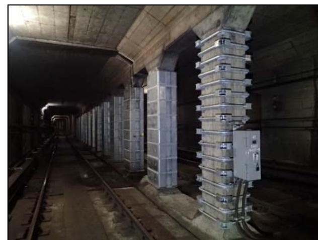
耐震補強状況（開削トンネル部）
