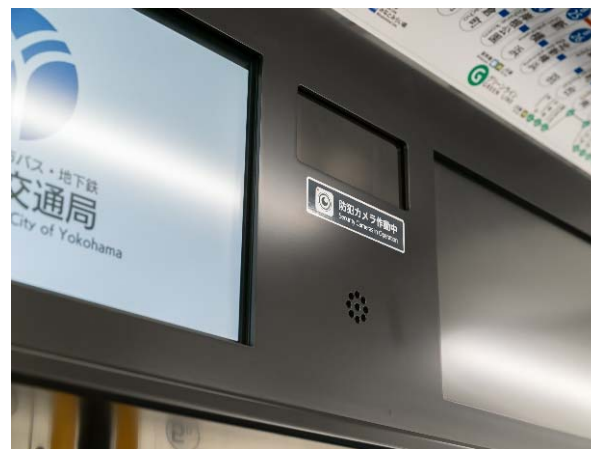
車内防犯カメラ（4000形）
