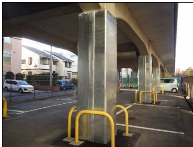
耐震補強状況（高架部）
