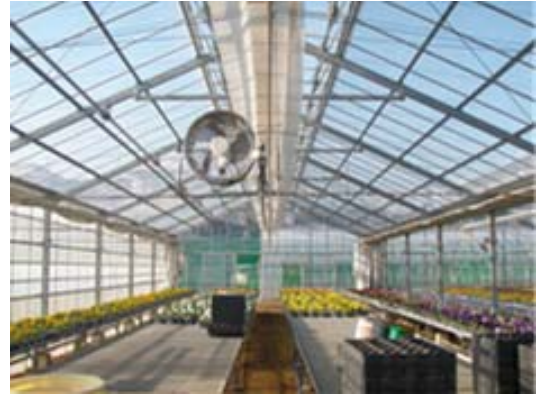
[写真] 循環扇を設置した温室
