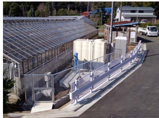
[写真] 井戸及び配管整備 (戸塚区/堤ヶ谷地区 畑地かんがい施設利用組合)
