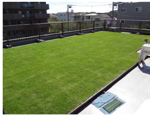
【写真】民間ビルの屋上緑化の事例 (港北区)
