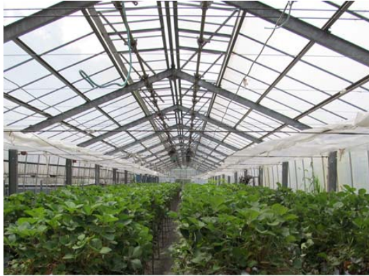
[写真] 保温カーテンを設置した温室
