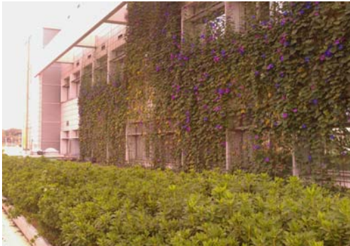
【写真】 公共施設の緑化の事例 (旭区/旭土木事務所)
