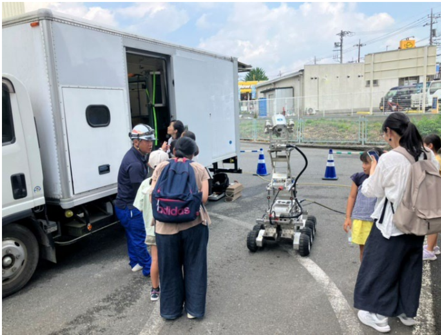
機材（グランドビーバー）を操作している様子
