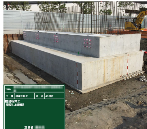
コンクリート基礎構築
