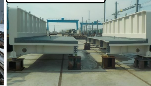
上部工断面(塗装後)
