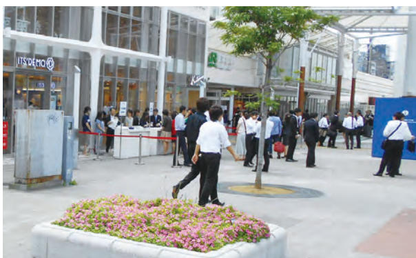
桜木町駅前広場の植栽工事
