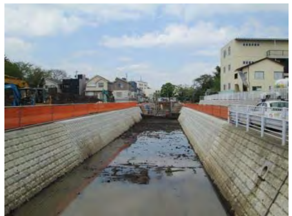
帷子川 三家橋下流
