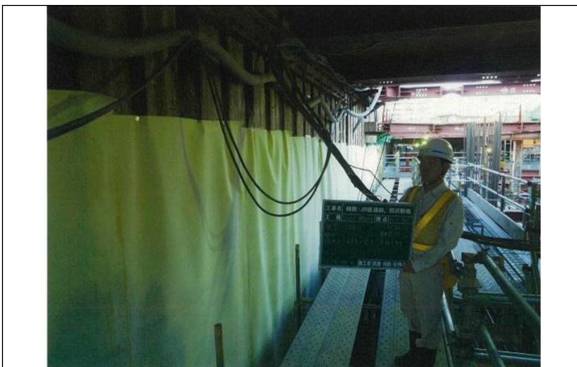
写真 3.4 環境保全のための措置の実施状況（防水シートの対策）
