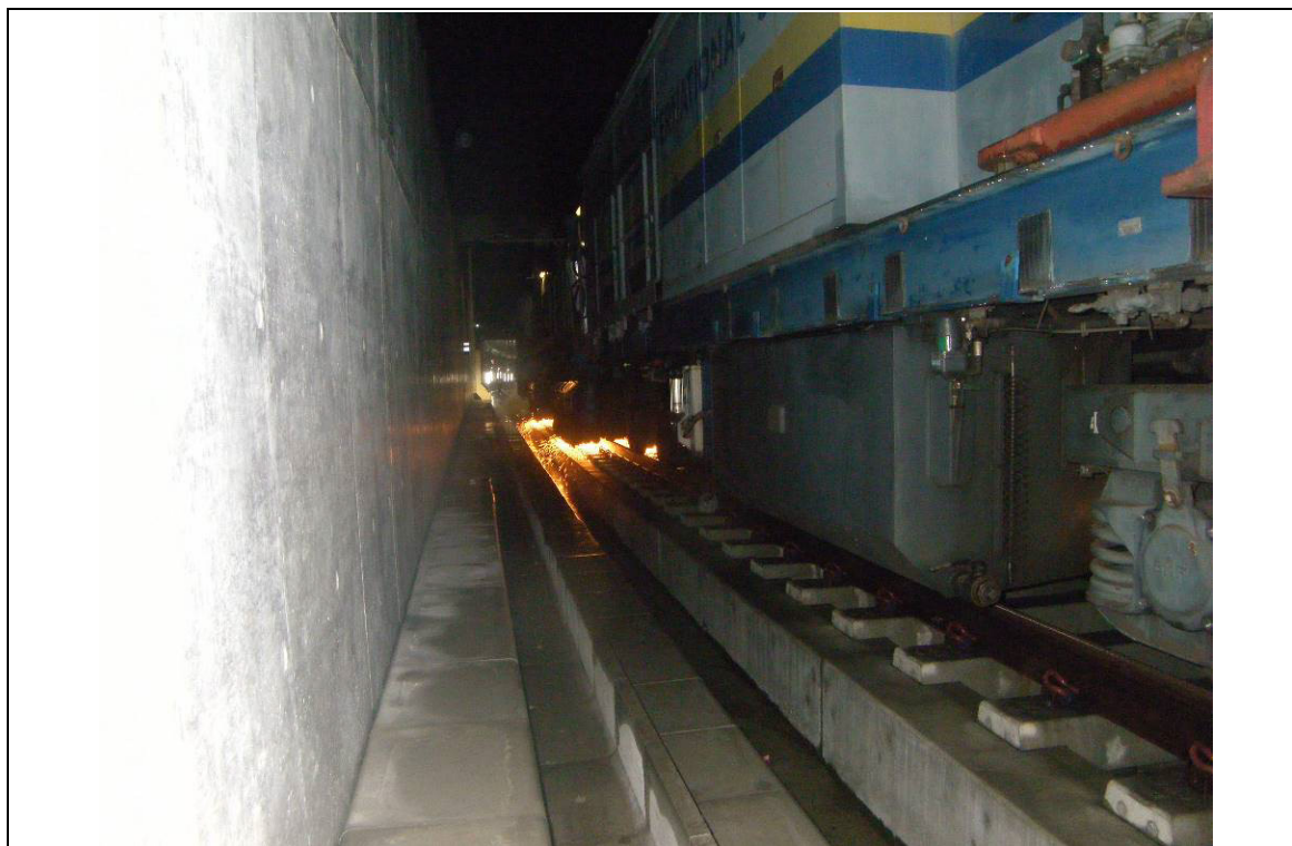
写真 3.2 環境保全のための措置の実施状況（レール削正による整備）
