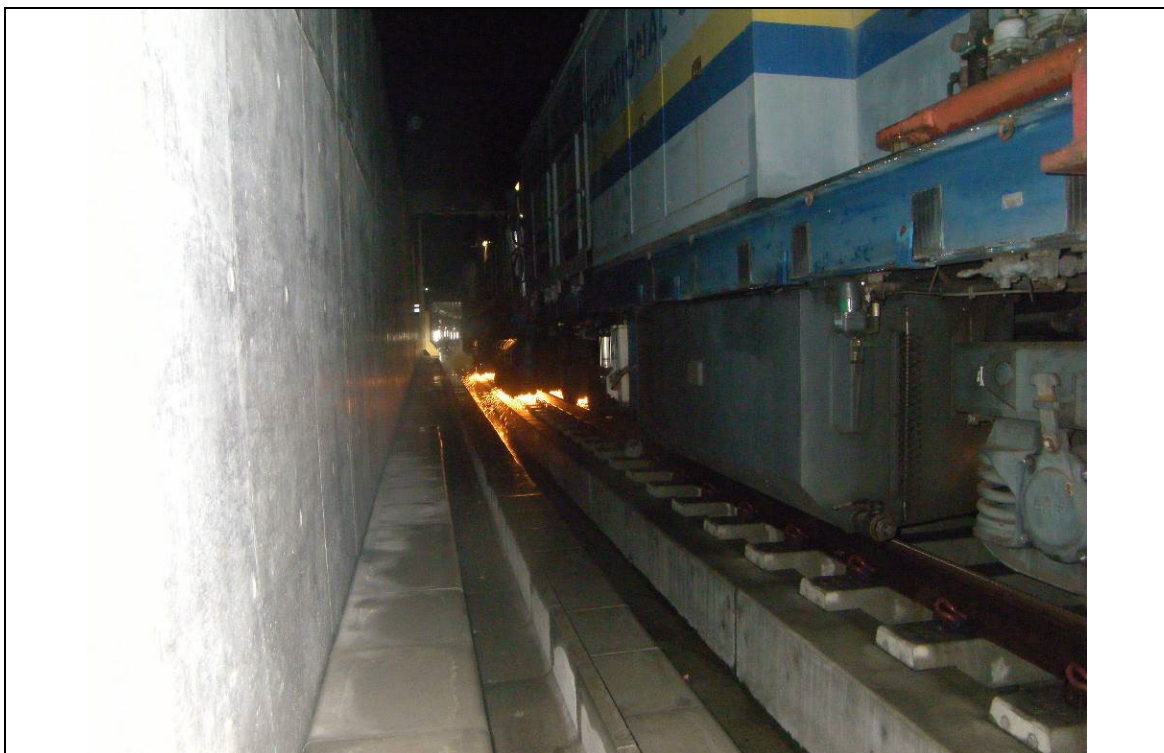
写真 3.1 環境保全のための措置の実施状況（レール削正による整備）
