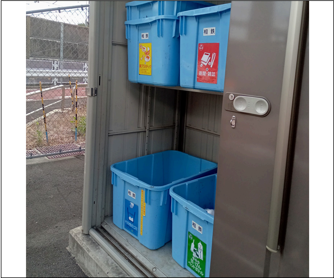
写真 3.3 環境保全のための措置の実施状況（廃棄物保管場所の設置状況）
