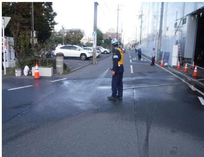
写真 2. 4. 4-2(1) 環境保全のための措置の実施状況（工事現場での散水）
