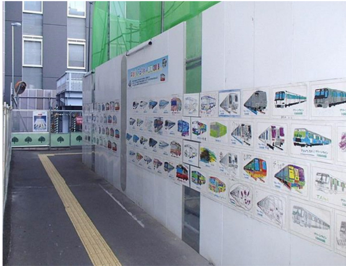
写真 2. 4. 4-1 (1) 環境保全のための措置の実施状況（仮囲いの設置①）
