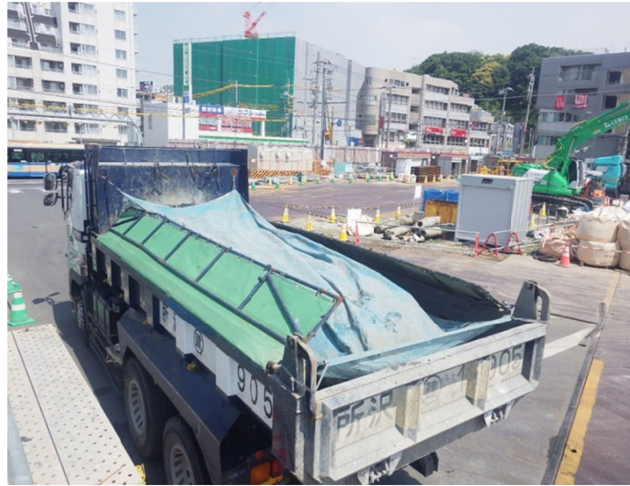
写真 2. 4. 4-3 環境保全のための措置の実施状況（工事用車両の荷台への防塵シートの敷設）
