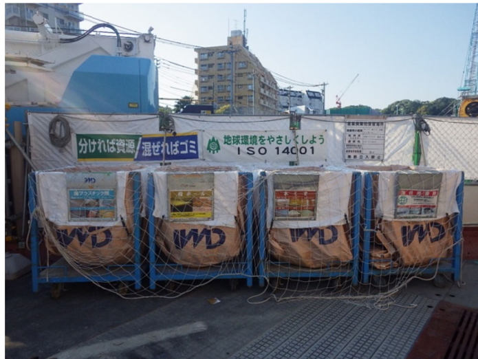
写真 2. 4. 3-1(1) 環境保全のための措置の実施状況 (建設廃棄物の分別処理)
