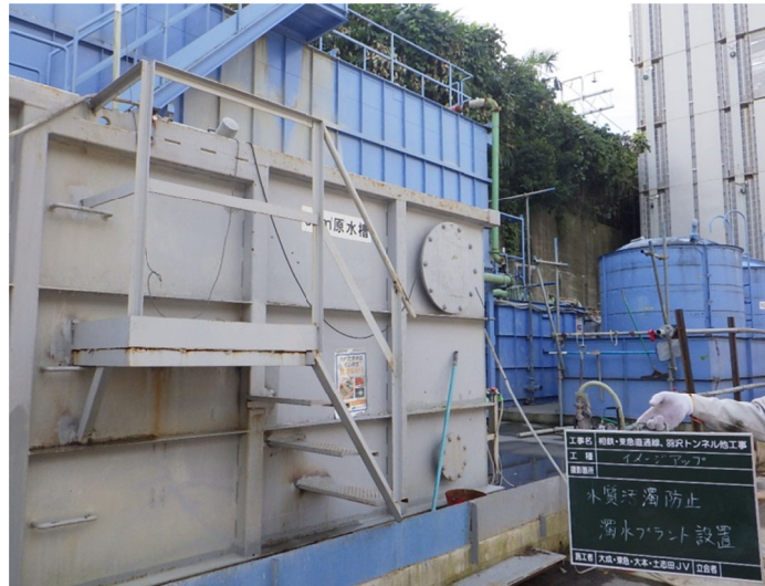
写真 2.4.4-6 環境保全のための措置の実施状況（濁水処理設備による排水処理）
