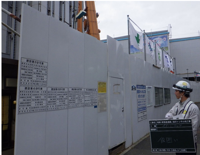
写真 2. 4. 4-1 (2) 環境保全のための措置の実施状況（仮囲いの設置②）
