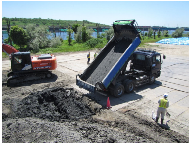
写真 2.4.3-1(4) 環境保全のための措置の実施状況（建設発生土の再利用）
