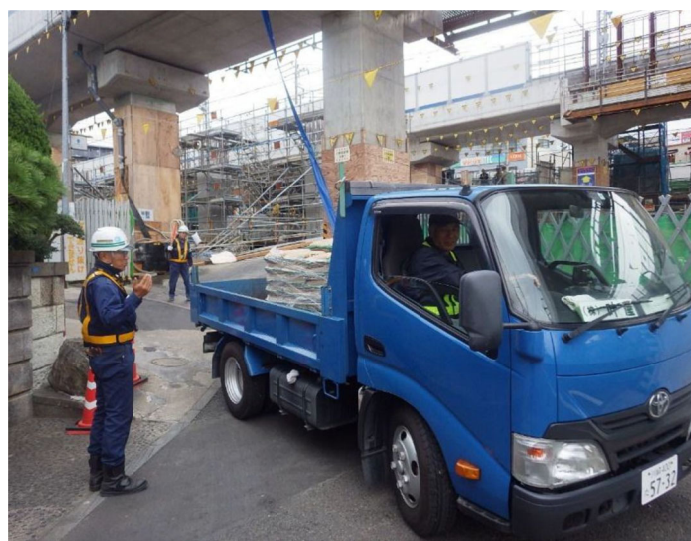
写真 2.4.4-9 環境保全のための措置の実施状況（通行者の誘導）
