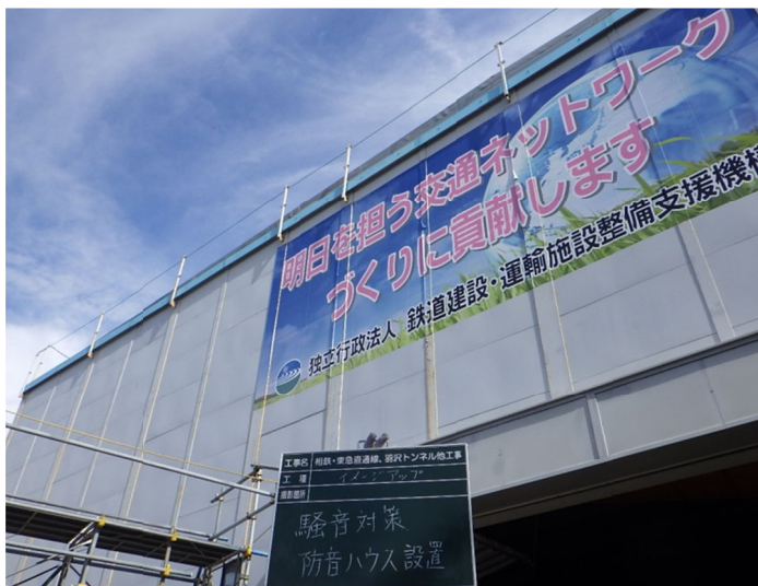
写真 2. 4. 4-1 (3) 環境保全のための措置の実施状況（防音ハウスの設置）
