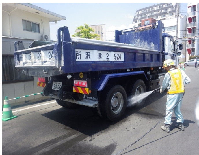
写真 2. 4. 4-2(3) 環境保全のための措置の実施状況（工事用車両のタイヤ洗浄）
