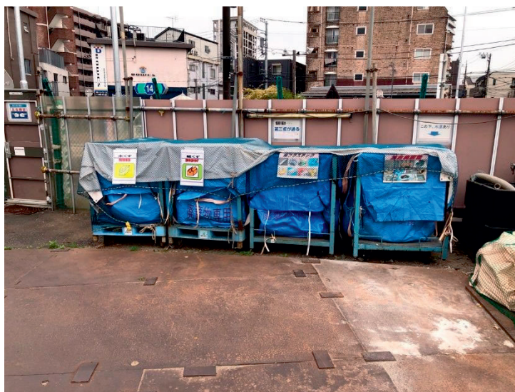
写真 2. 4. 3-1 環境保全のための措置の実施状況（建設廃棄物の分別処理）
