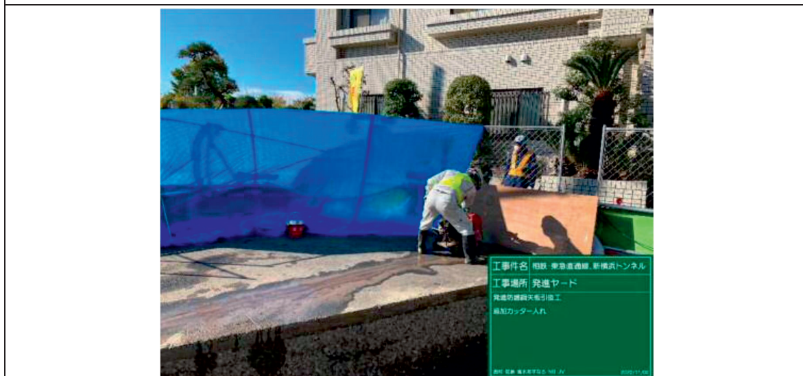
写真 2.4.4-1(2) 環境保全のための措置の実施状況（飛散防止シートの設置）
