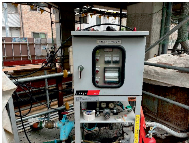
写真 2. 4. 4-4 環境保全のための措置の実施状況（濁水処理設備による排水処理）
