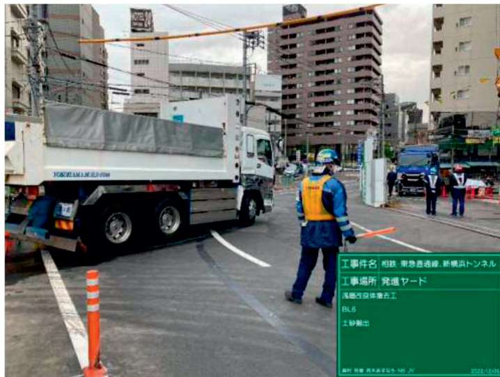
写真 2.4.4-7 環境保全のための措置の実施状況（車両誘導員の配置）
