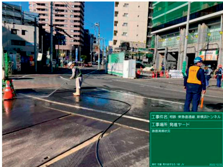
写真 2. 4. 4-2 (1) 環境保全のための措置の実施状況（工事現場での散水）
