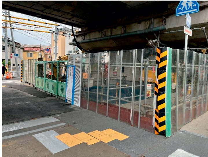
写真 2. 4. 4-1 (3) 環境保全のための措置の実施状況（建設機械稼働箇所への仮囲いの設置）
