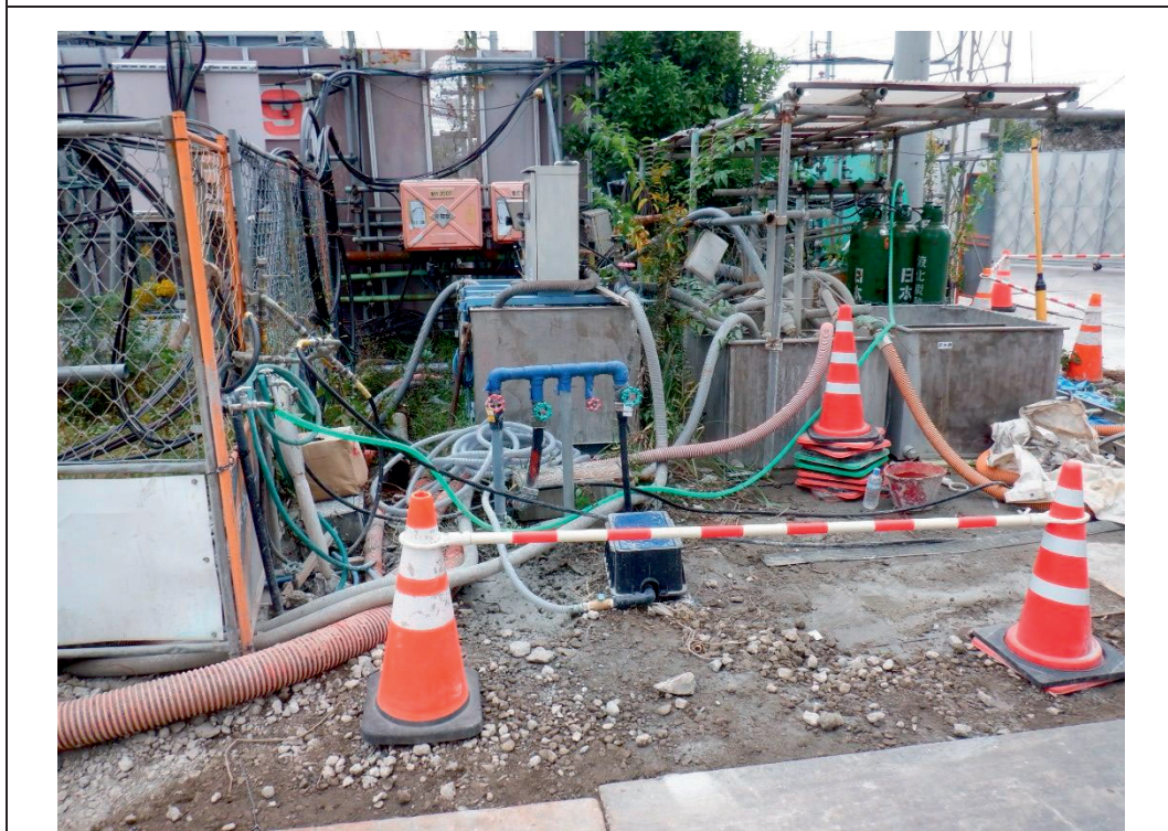
写真 2. 4. 1-2 環境保全のための措置の実施状況（リチャージウェルの実施）
