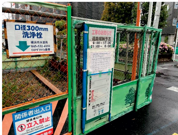
写真 2. 4. 4-6(2) 環境保全のための措置の実施状況（工事計画の周知：工事案内掲示板②）
