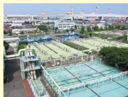
中部水再生センター
