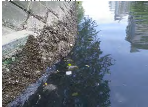
調査環境 (O4壁面)
