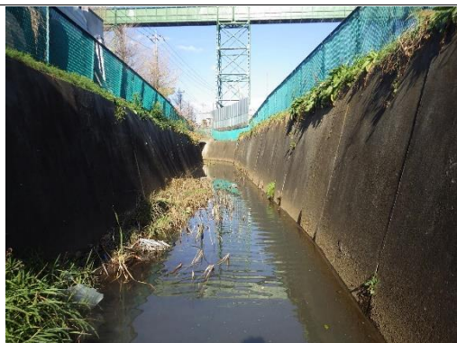
K1 帷子川 大貫橋上流(冬季)
