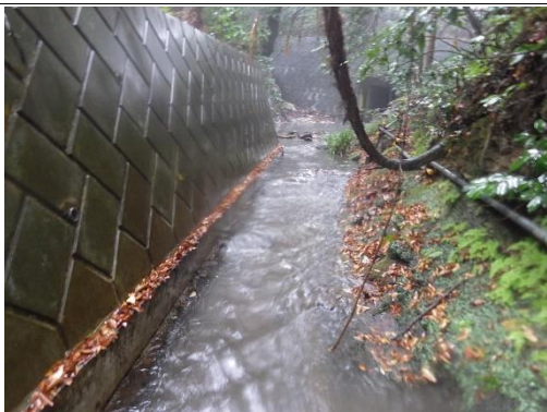
J1 侍従川 金の橋上流(冬季)
