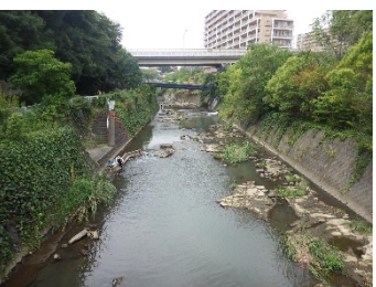
帷子川 鶴舞橋
