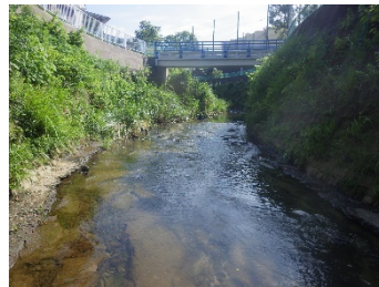
大岡川 曲田橋
