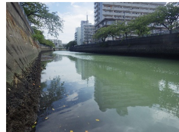
大岡川 井土ヶ谷橋
