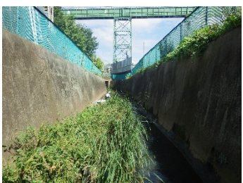
帷子川 大貫橋上流
