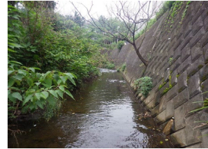
大岡川 陣屋橋上流
