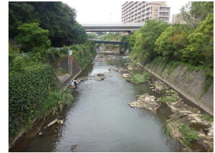
帷子川 鶴舞橋
