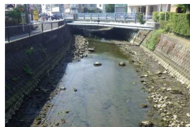
侍従川 六浦二号橋
