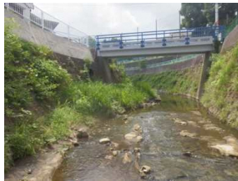
大岡川 曲田橋
