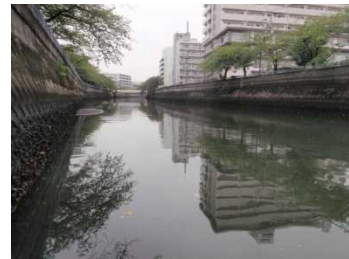
大岡川 井土ヶ谷橋
