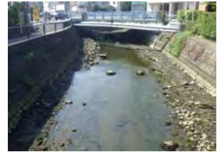
侍従川 六浦二号橋
