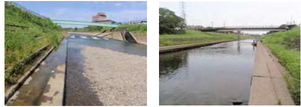
境川 遊水地橋 S水再生センター下流
